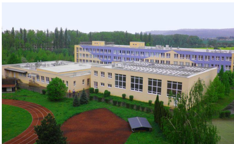
Pohled na školu od školního hřiště
