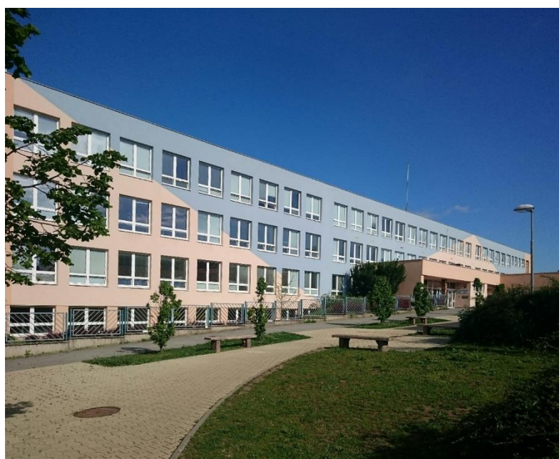
Učebnový pavilon – vstup do budovy
