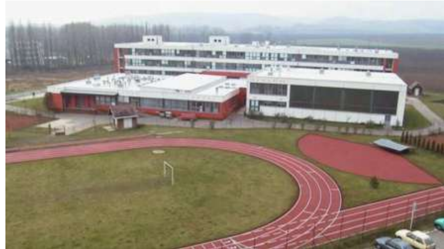
Celkový pohled na školu před rekonstrukcí se sportovním areálem
