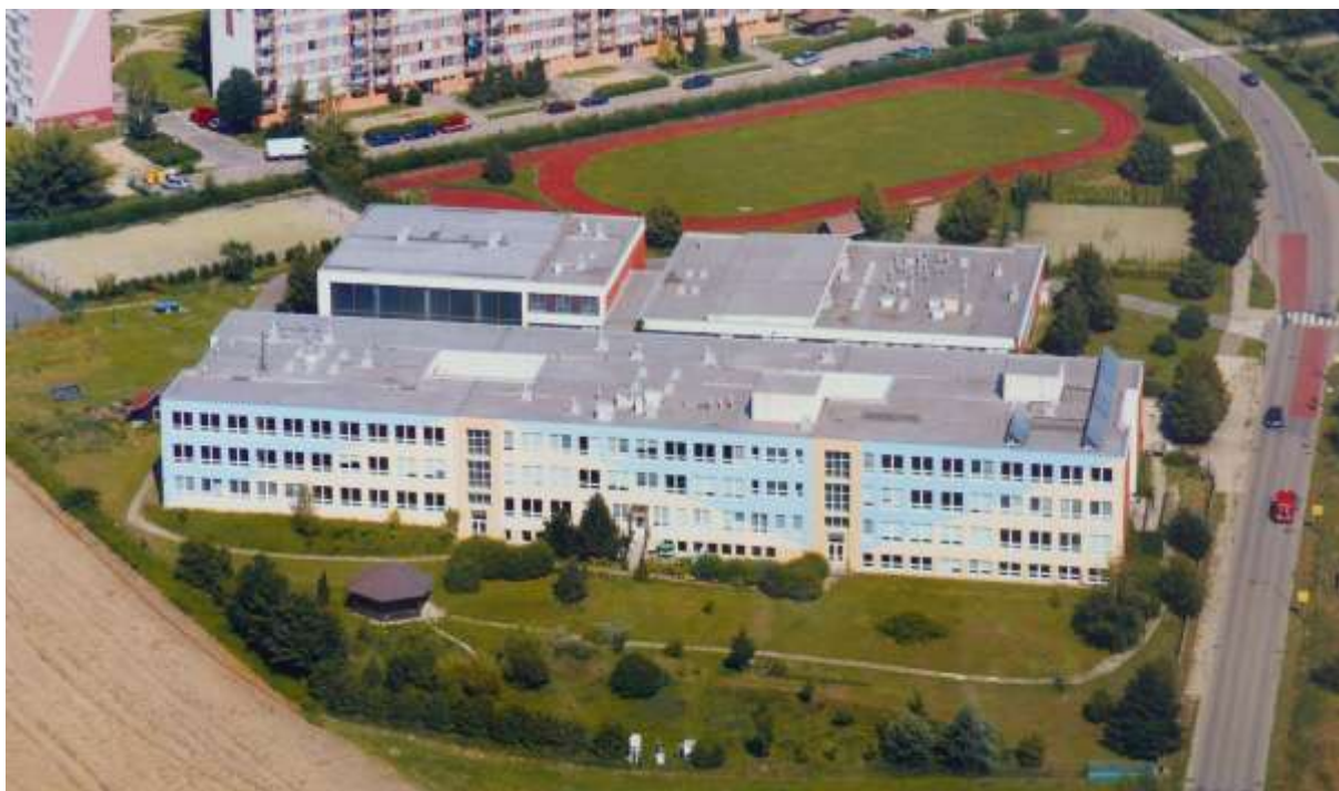
LETECKÝ POHLED NA AREÁL ŠKOLY
