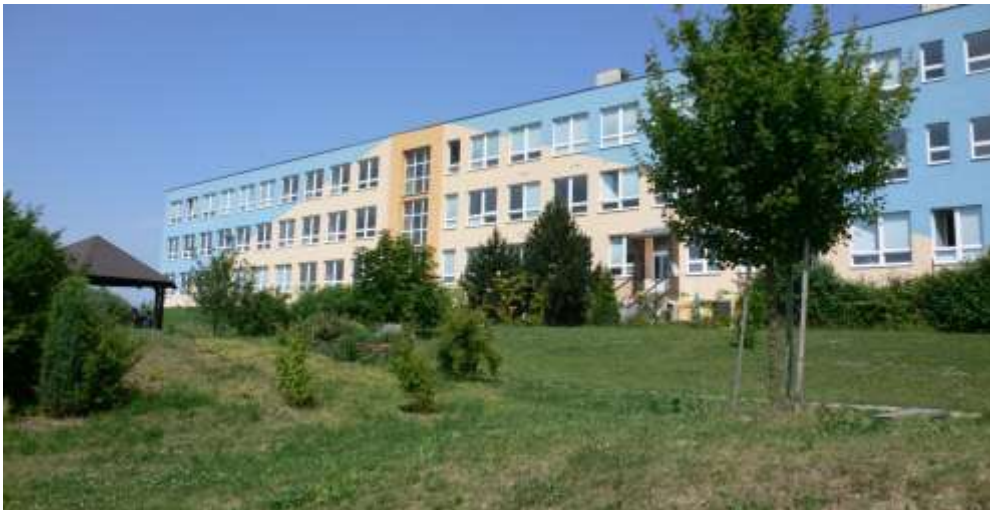
Pohled na část budovy, kde v r. 2006 a 2007 proběhla výměna oken a zateplení fasády (v roce 2011 byly dokončeny práce na rekonstrukci zbytku budovy)
