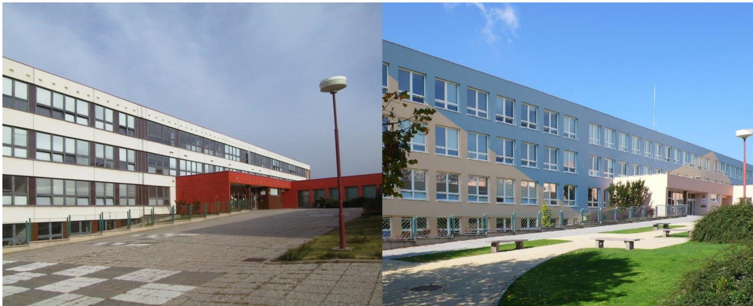
Prostranství před hlavním vstupem (před a po rekonstrukci)
