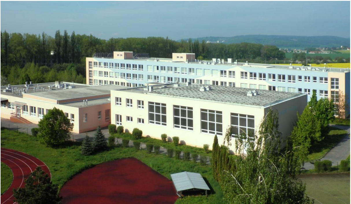
POHLED NA ŠKOLU PO REKONSTRUKCI
