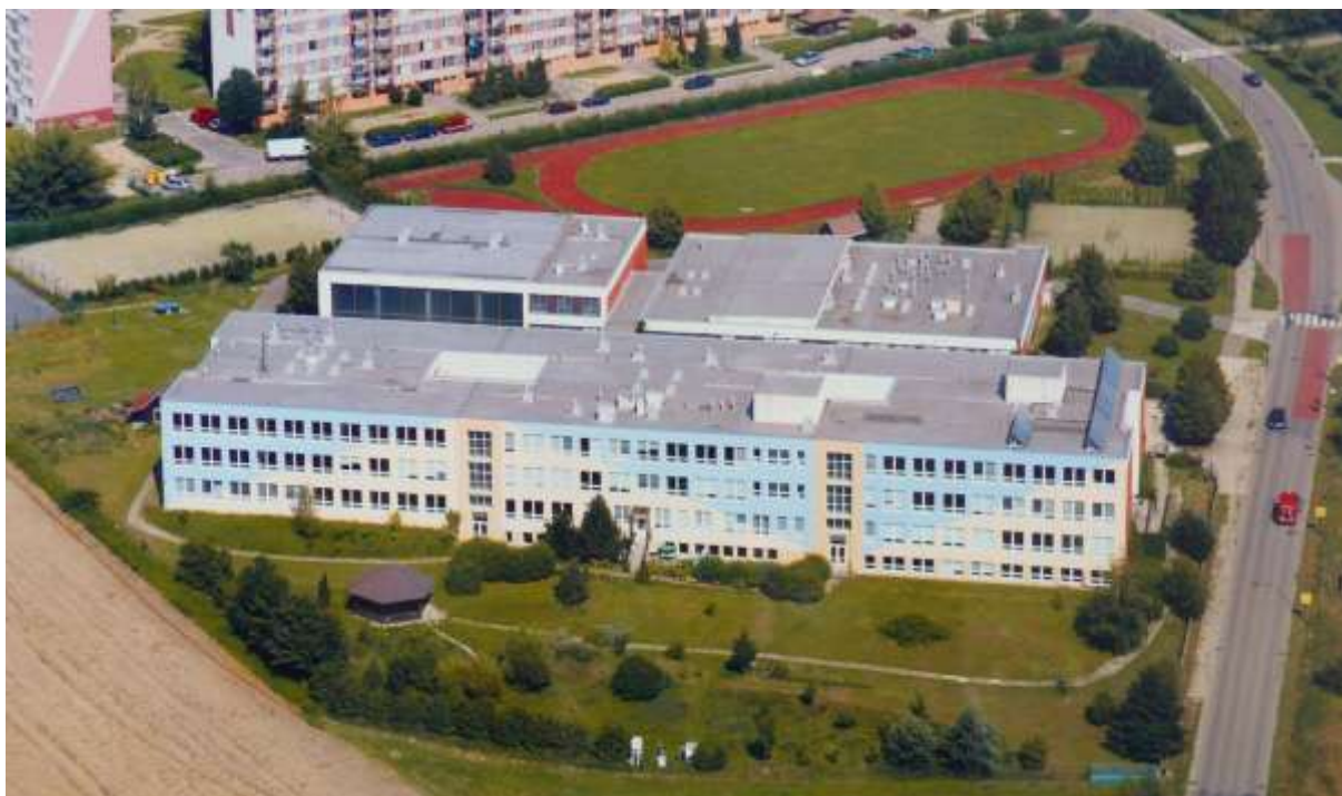
LETECKÝ POHLED NA AREÁL ŠKOLY
