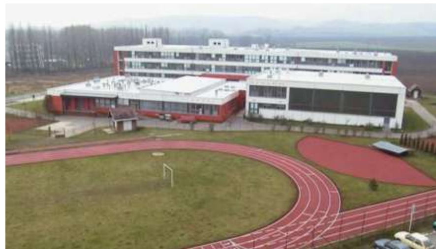
Celkový pohled na školu před rekonstrukcí se sportovním areálem
