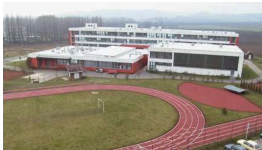
Celkový pohled na školu se sportovním areálem
