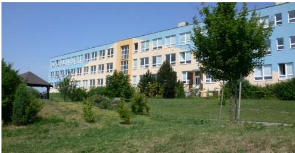
Pohled na část budovy, kde v r. 2006 a 2007 proběhla výměna oken a zateplení fasády
